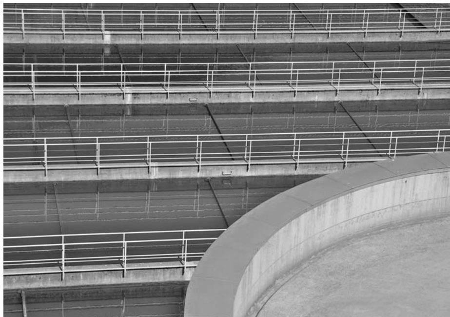
Abb. 3.71 Nachklärbecken und Faulturm der ARA in Chur
